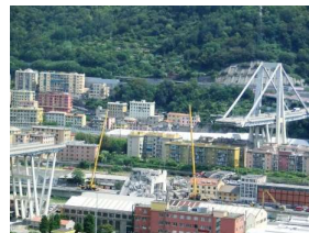
Viaduc de Polcevera, Genova, 2018 (09-1967)
